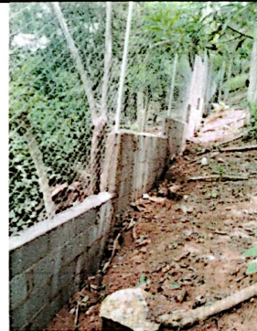
Foto 4: Se puede observar el muro ya instalado desde otro ángulo.
