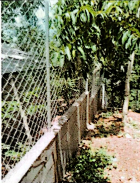
Foto 1: Se puede observar el muro perimetral ya instalado en su totalidad en la parte de abajo de la escuela.
