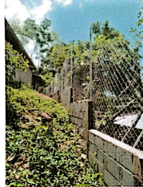
Foto 2: Se puede observar el muro ya instalado desde otro ángulo.
