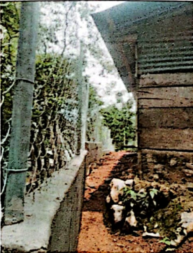
Foto 3: Se puede observar el muro ya instalado desde otro ángulo.
